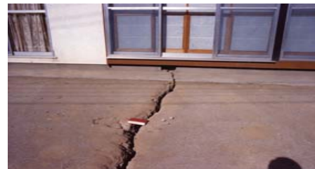
宮城県沖地震（1978）による不同沈下 (提供：山形大学 村山良之氏)
