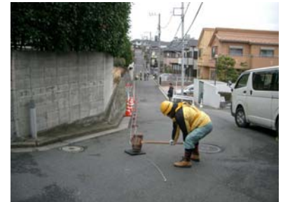
写真2 表面探査試験の実施風景 「大規模盛土造成地の変動予測調査ガイドラインの解説(案)」 (国土交通省都市・地域整備局（平成20年）)
