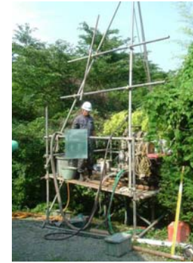
写真1 調査ボーリング実施風景
